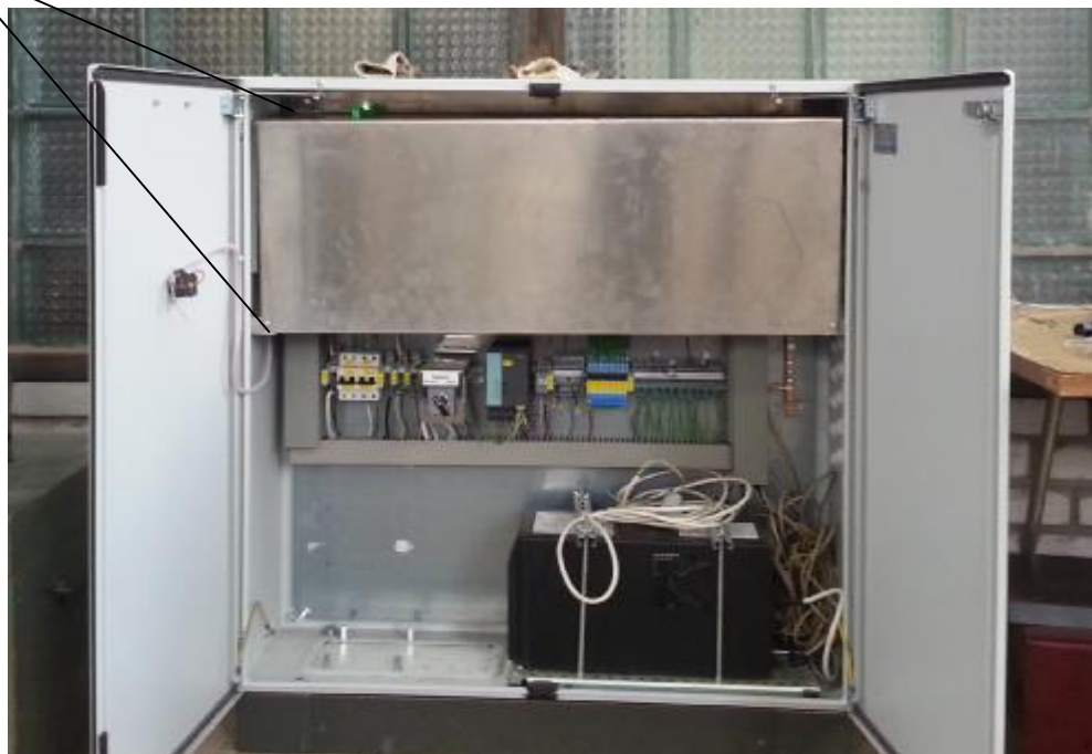
Рисунок 2 Места опломбирования ЛТС1
