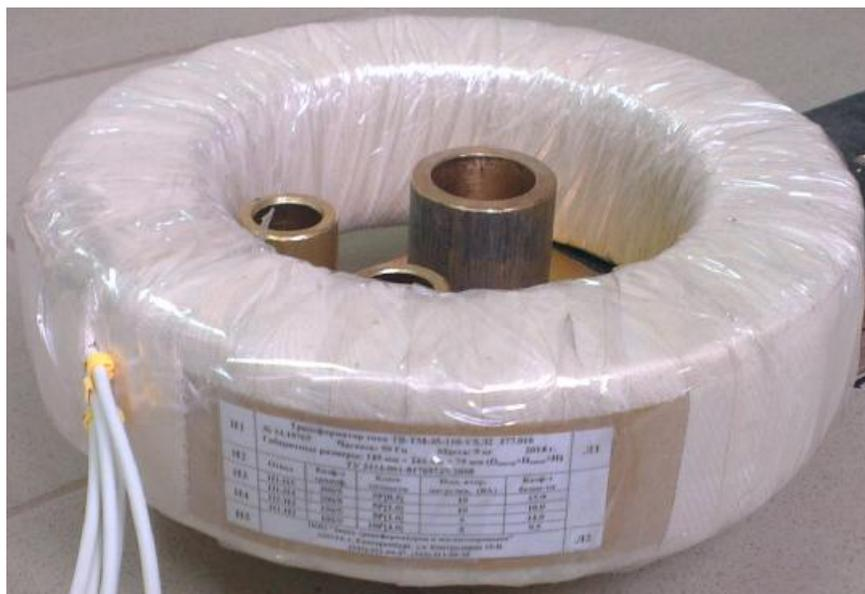
Рис. 1 – Трансформатор тока ТВ-ТМ-35
