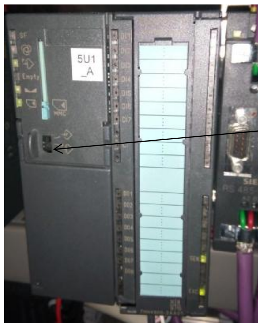
Рисунок 3 – Схема пломбирования модуля многофункционального SIWAREX FTA
