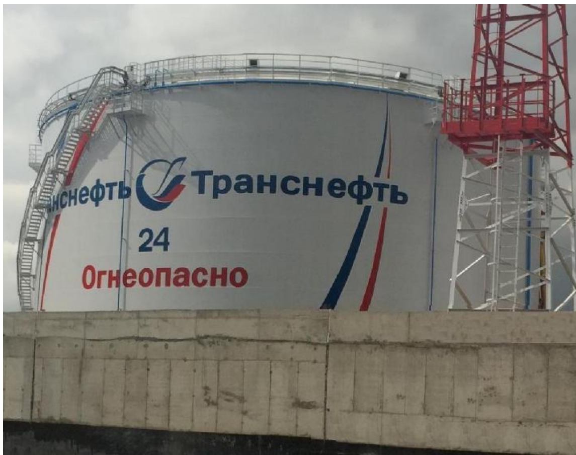
Рисунок 2 – Общий вид резервуара №24
