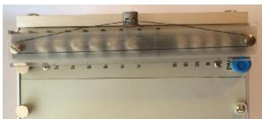
Рисунок 9 - Пломбировка клеммных соединителей измерительных цепей
