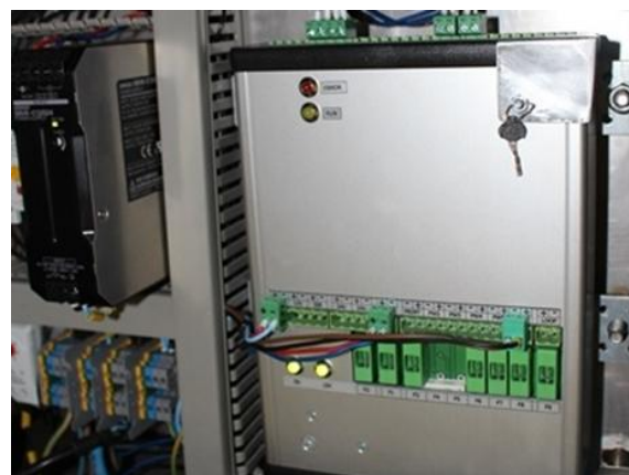
Рисунок 7 - Схема пломбирования защитной крышки вычислителя
