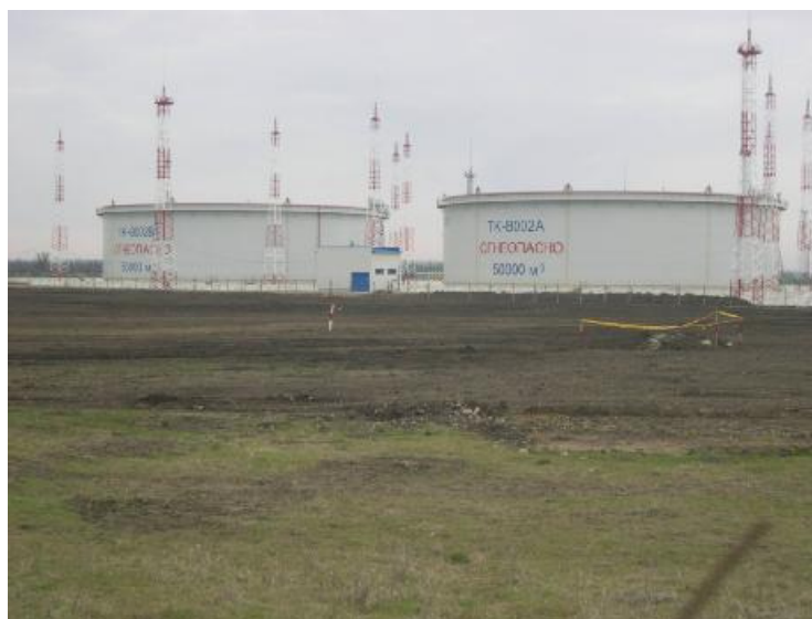
Рисунок 1 – Общий вид резервуара
