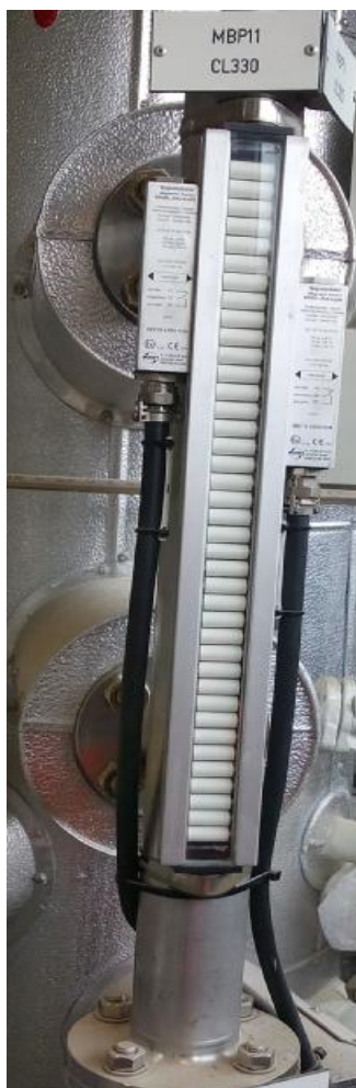
Рисунок 2 - Общий вид указателя уровня (фото)
