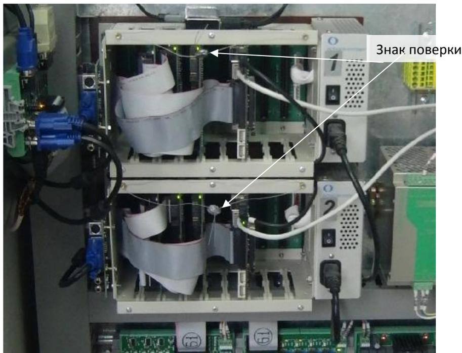
Рисунок 2 – Места установки поверительных пломб
