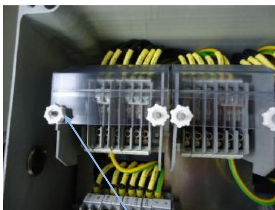
Рисунок 4 - Место пломбирования (в клеммной коробке)
