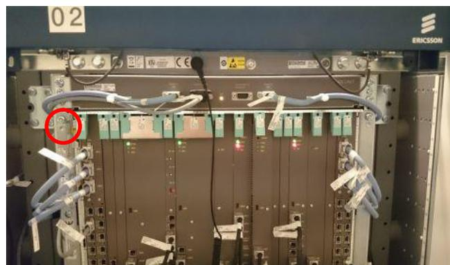
Рисунок 2 - Место блокировки кассетного модуля (выделено)
