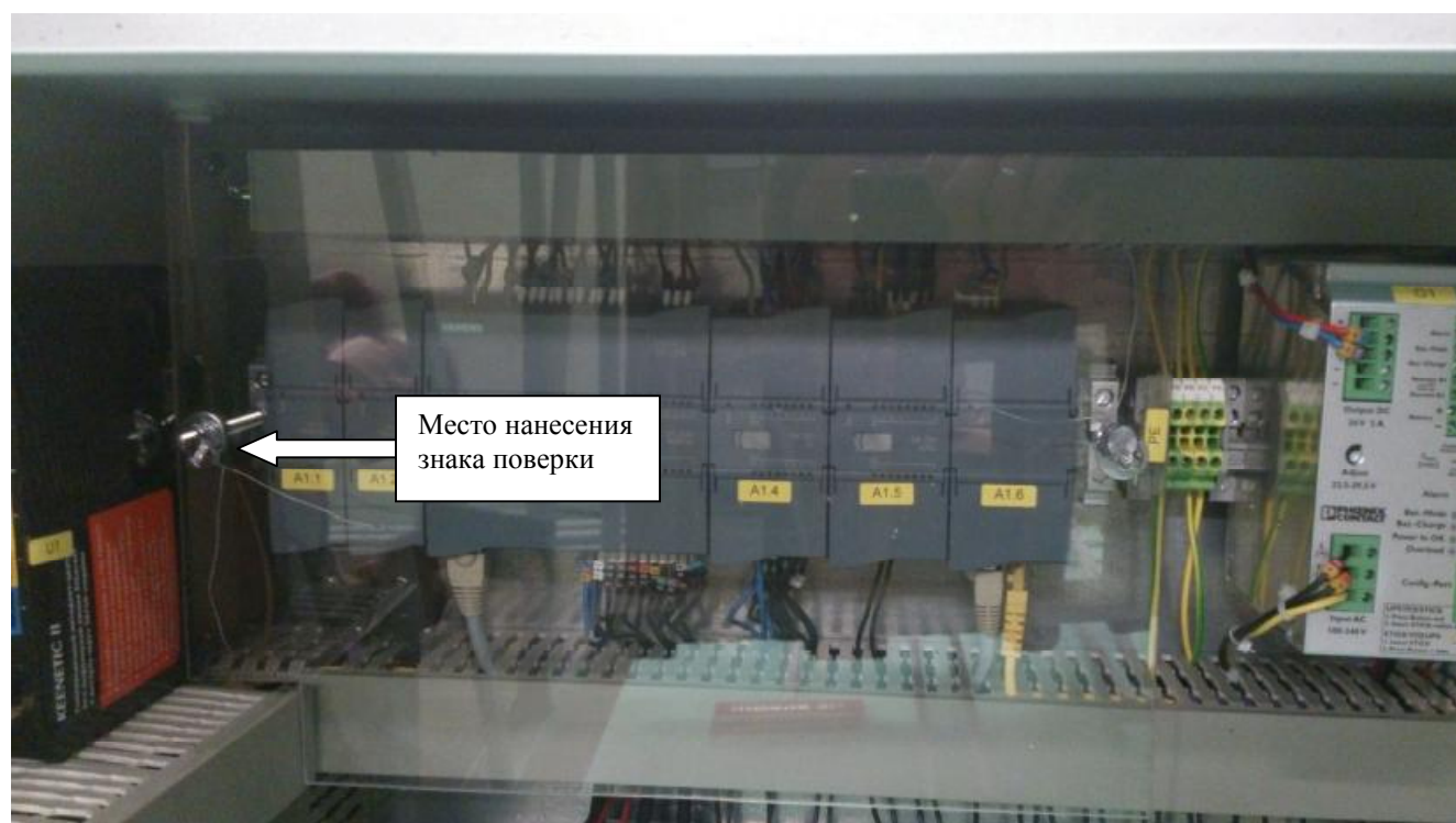
Рисунок 1 – Место пломбирования комплекса знаком поверки
