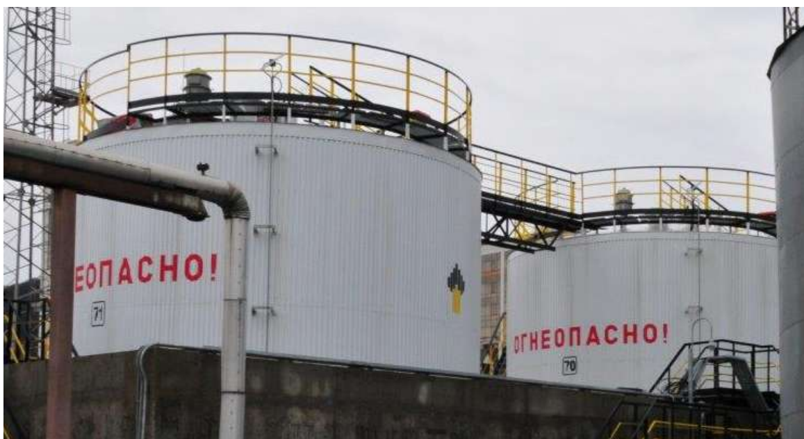
Рисунок 1 - Общий вид резервуаров
