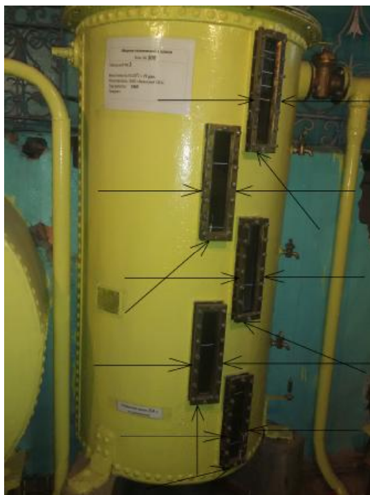
Рисунок 1 - Внешний вид и схема пломбировки мерника
