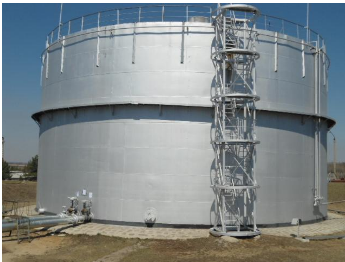
Рисунок 1 - Общий вид резервуара РВС-5000
