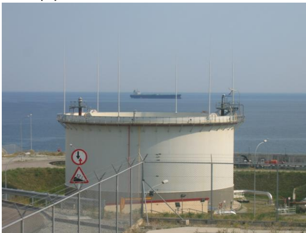
Рисунок 1 – Общий вид резервуаров РВСПК-10000
