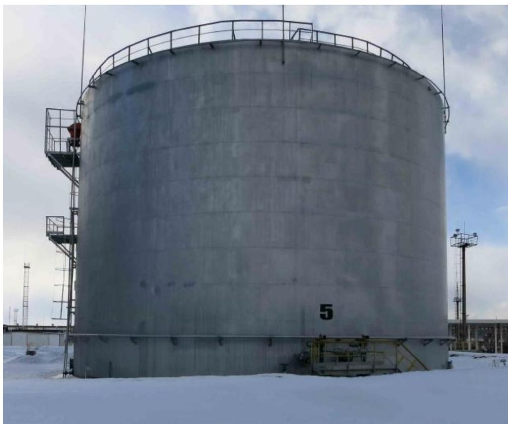
Рисунок 1 – Общий вид резервуаров РВС-5000
