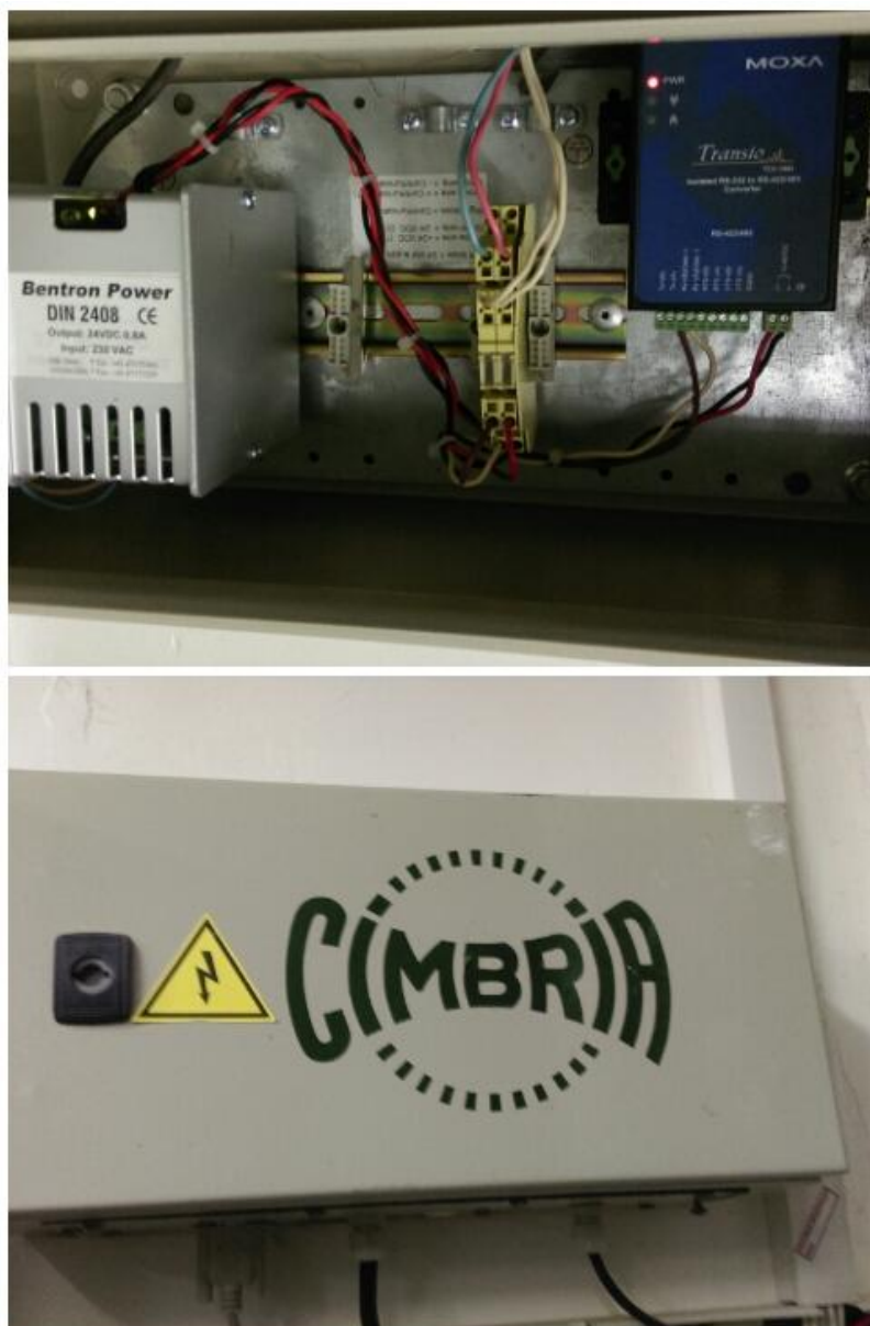
Рисунок 1. Преобразователь интерфейсов Uniface 3000 W модели CUT 3002-0110 с блоком питания в защитном шкафу
