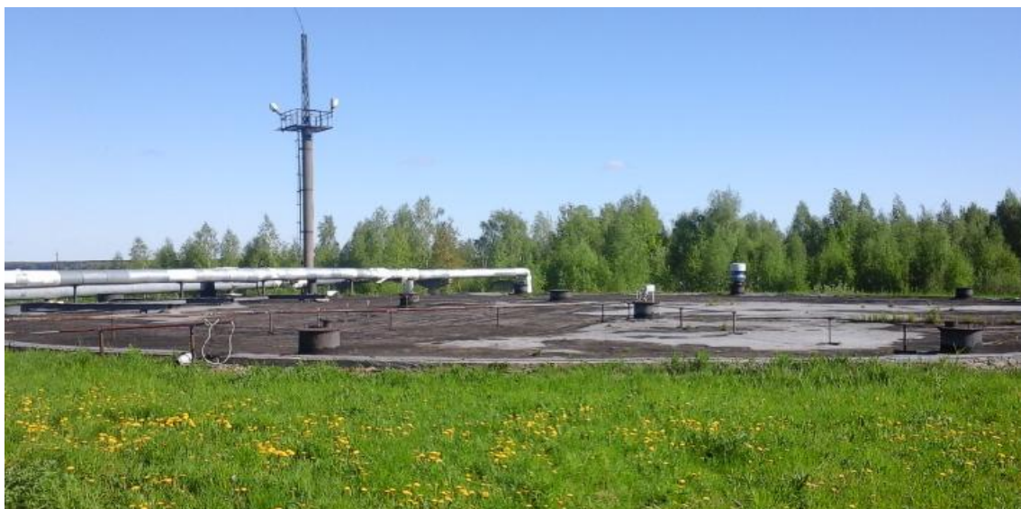
Рисунок 2 - Общий вид резервуара ЖБР-10000 №3
