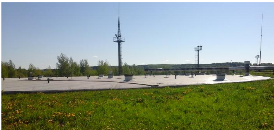
Рисунок 4 - Общий вид резервуара ЖБР-30000 №10
