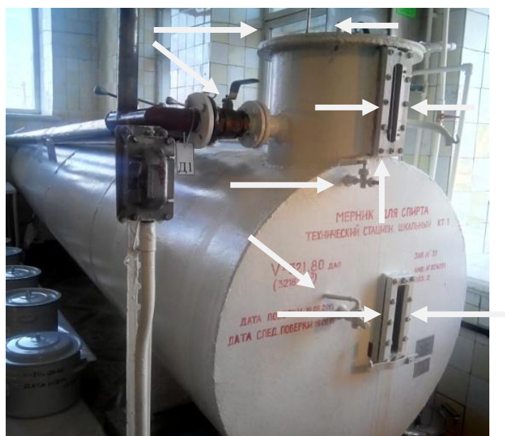
Рисунок 1 - Общий вид и места пломбирования мерника
