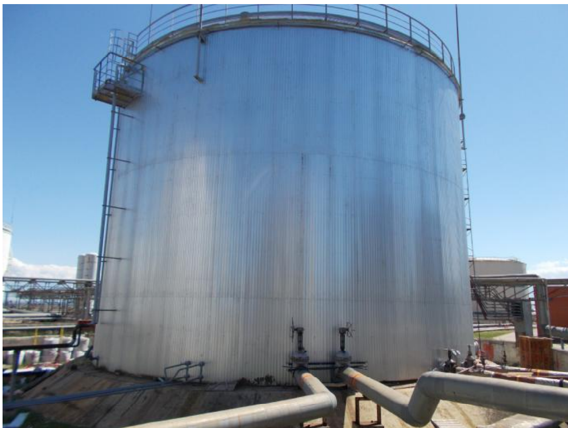
Рисунок 1- Общий вид резервуара № 17
