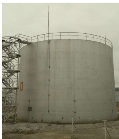
Рисунок 1 - Общий вид резервуара
