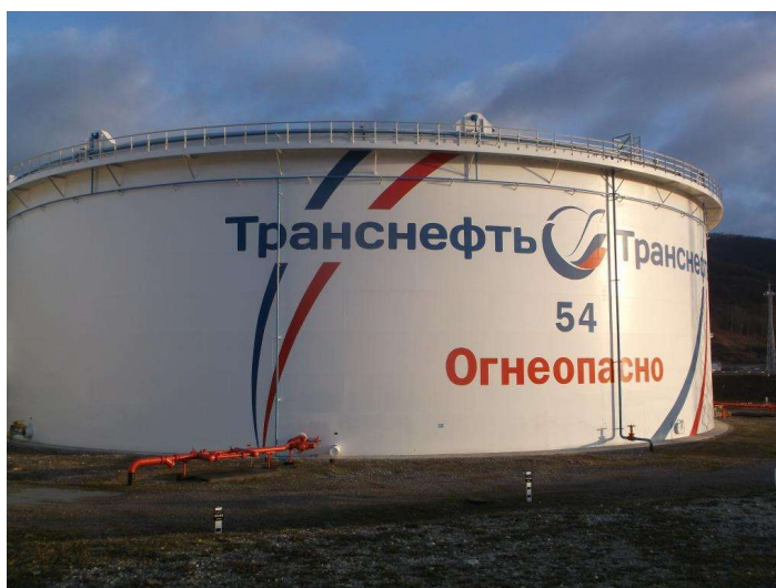
Рисунок 1 - Общий вид резервуара
