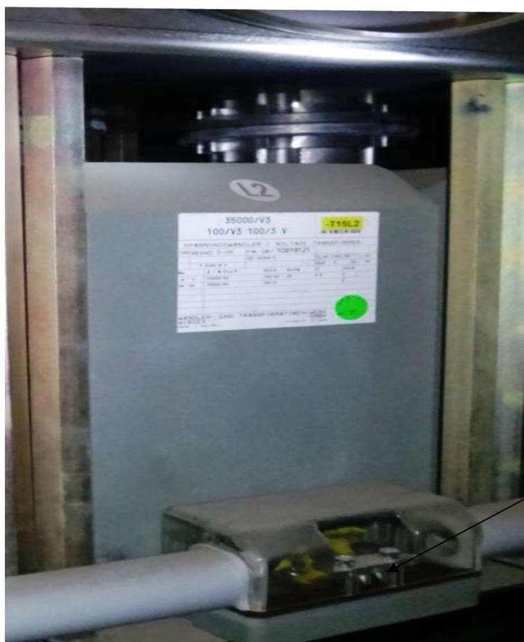
Рисунок 1 - Внешний вид и место пломбирования трансформаторов
