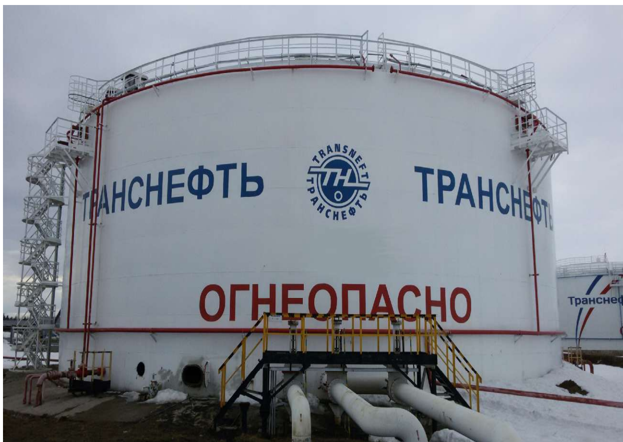
Рисунок 1 - Общий вид резервуара вертикального стального цилиндрического РВС-10000
