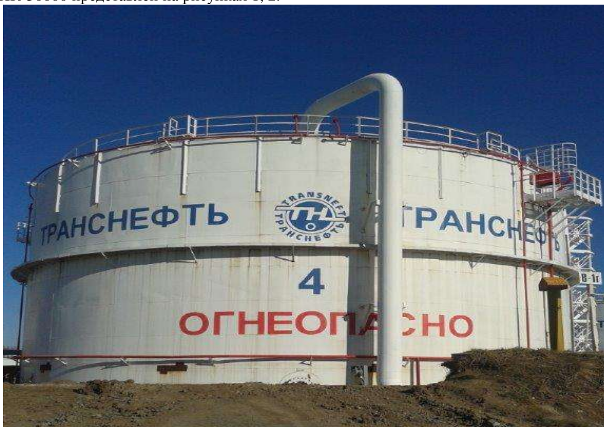
Рисунок 1 - Общий вид резервуара вертикального стального цилиндрического РВС-5000
