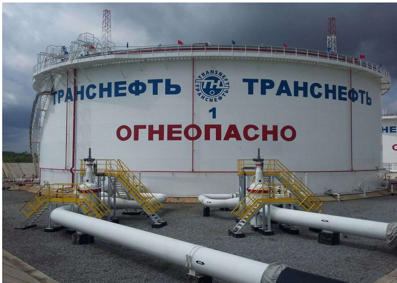
Рисунок 2 - Общий вид резервуара вертикального стального цилиндрического с плавающей крышей РВСПК-50000
