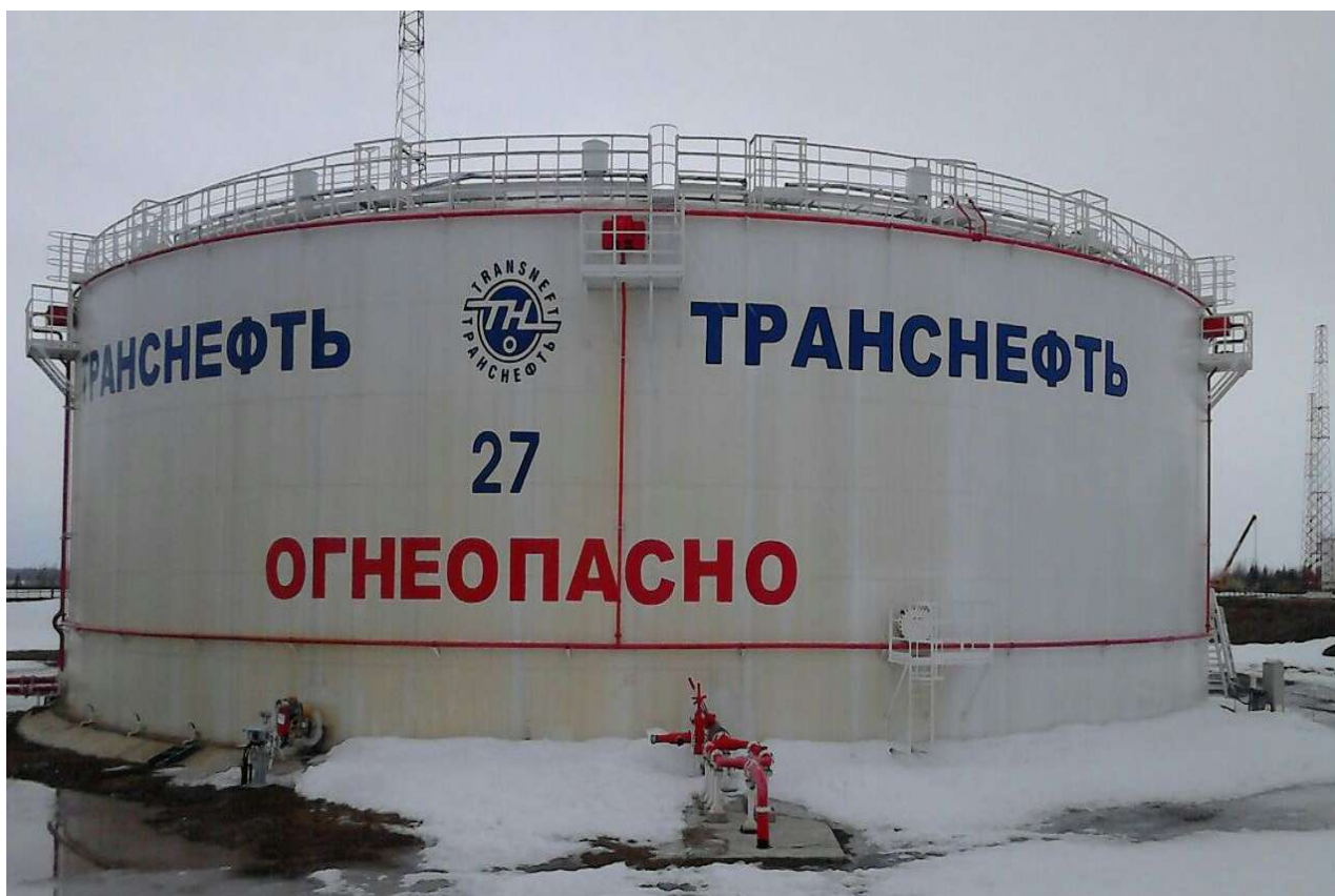
Рисунок 2 - Общий вид резервуара вертикального стального цилиндрического RVSP-20000
