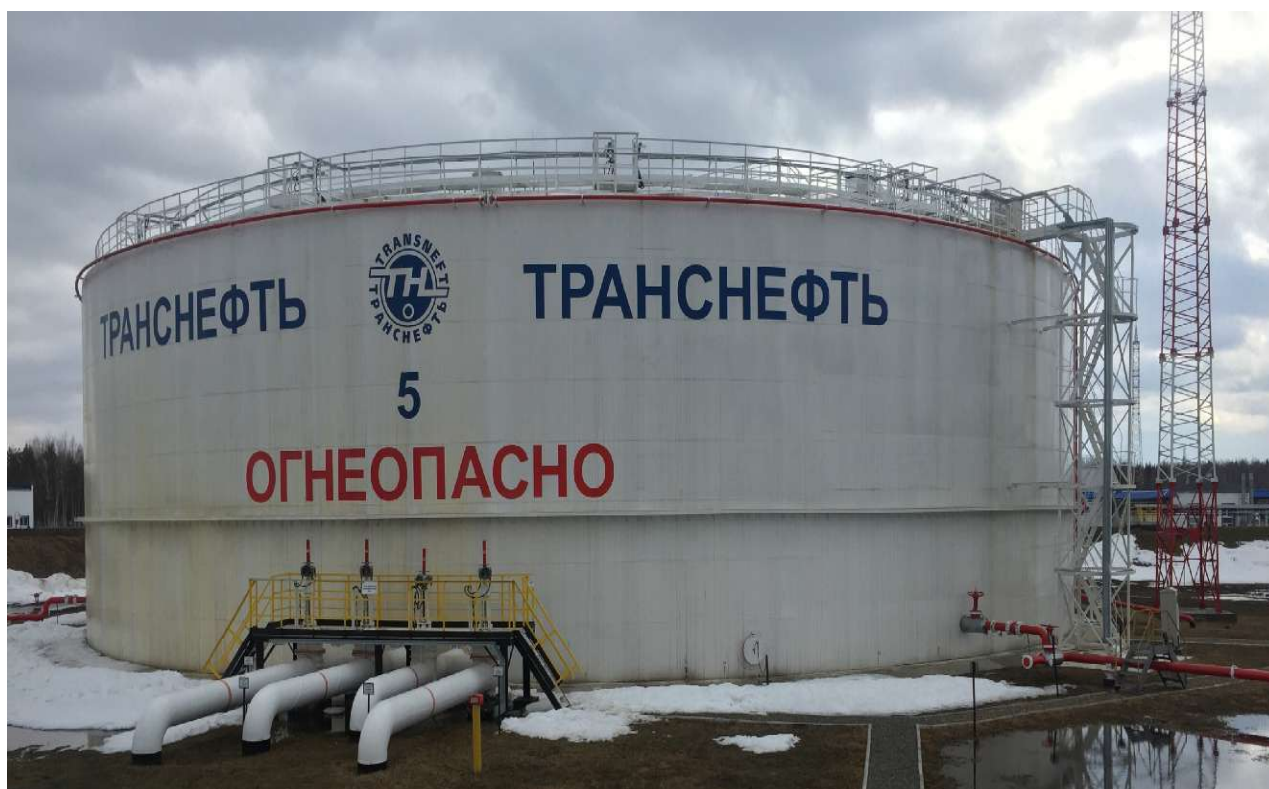
Рисунок 1 - Общий вид резервуара вертикального стального цилиндрического РВС-20000
