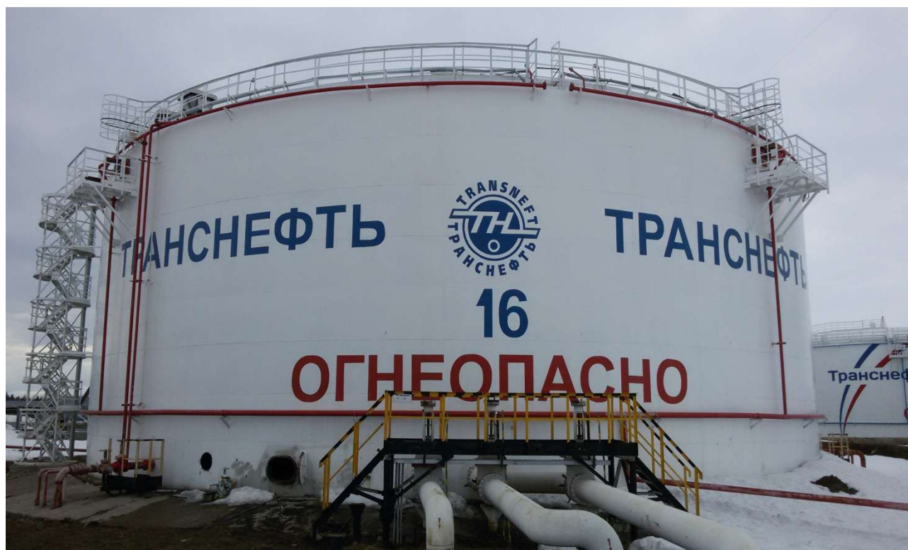
Рисунок 3 - Общий вид резервуара вертикального стального цилиндрического РВС-10000
