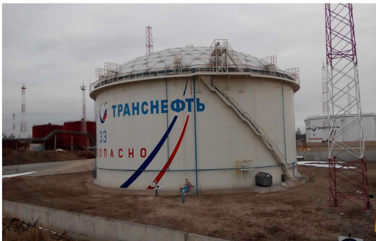
Рисунок 6 - Общий вид резервуара вертикального стального цилиндрического РВСП-30000
