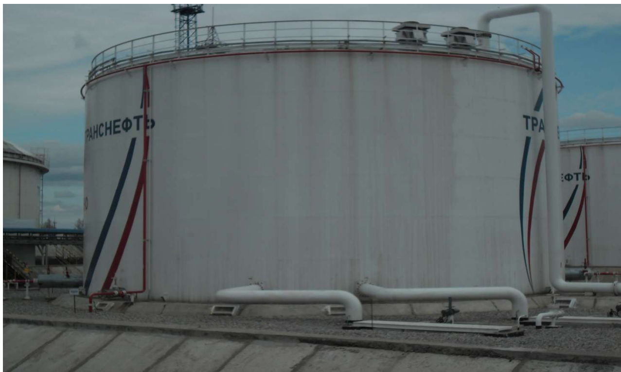
Рисунок 2 - Общий вид резервуара вертикального стального цилиндрического РВСП-5000
