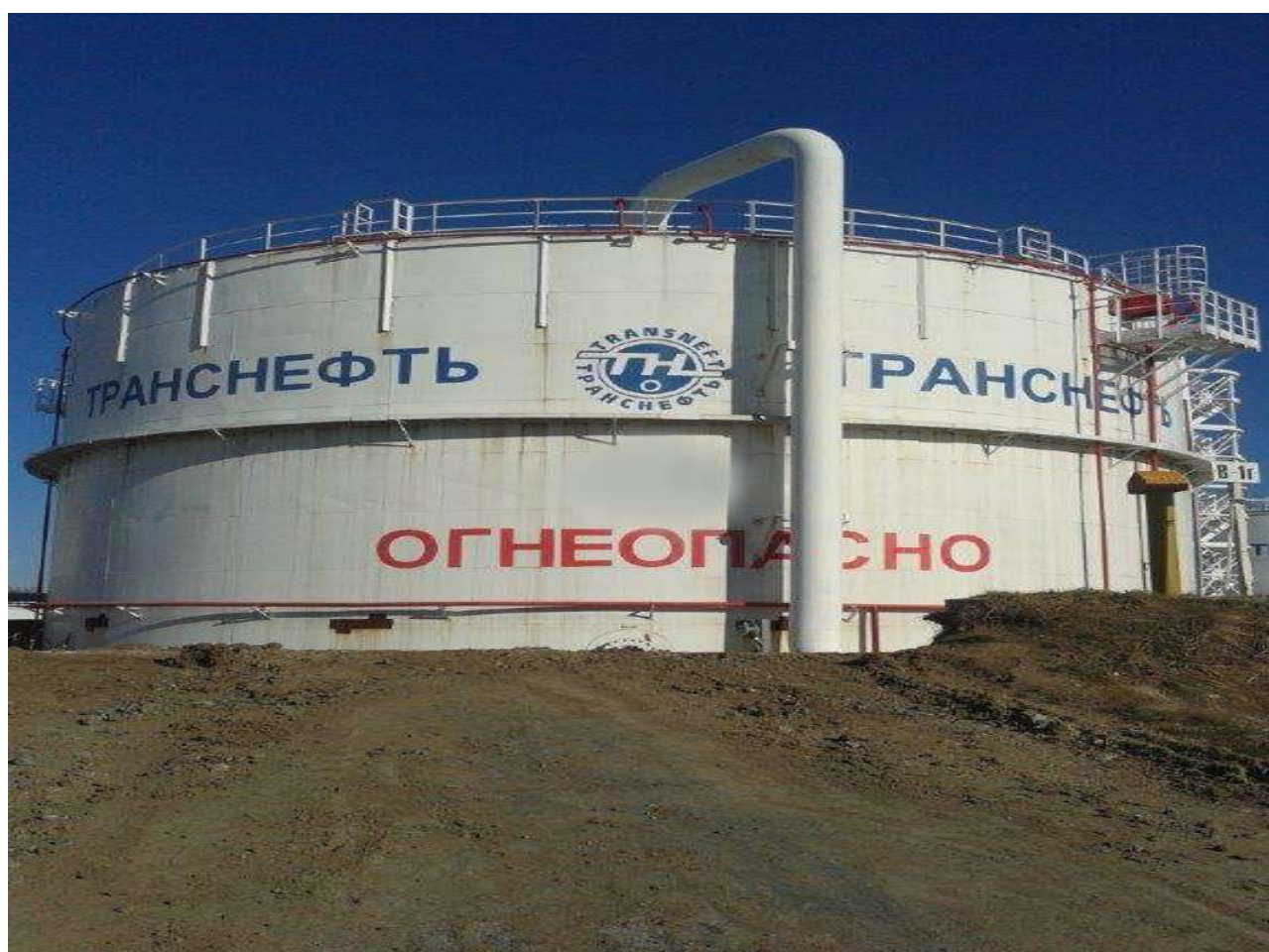
Рисунок 1 - Общий вид резервуара вертикального стального цилиндрического РВС-5000
