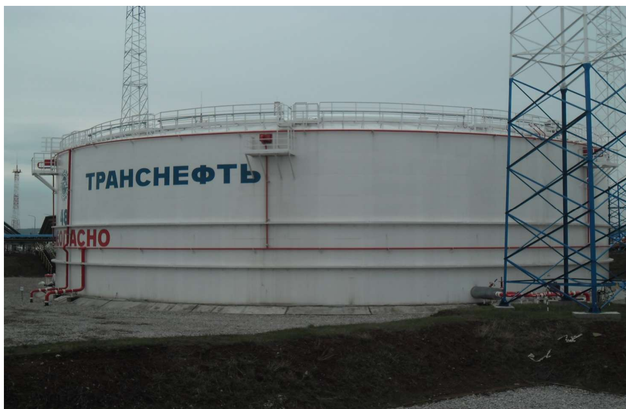
Рисунок 5 - Общий вид резервуара вертикального стального цилиндрического РВС-20000
