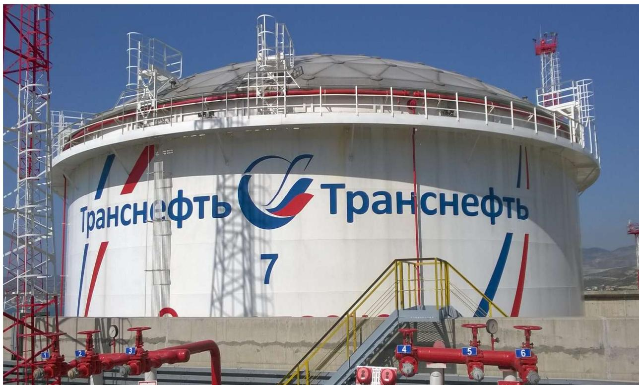
Рисунок 2 - Общий вид резервуара вертикального стального цилиндрического РВСП-10000
