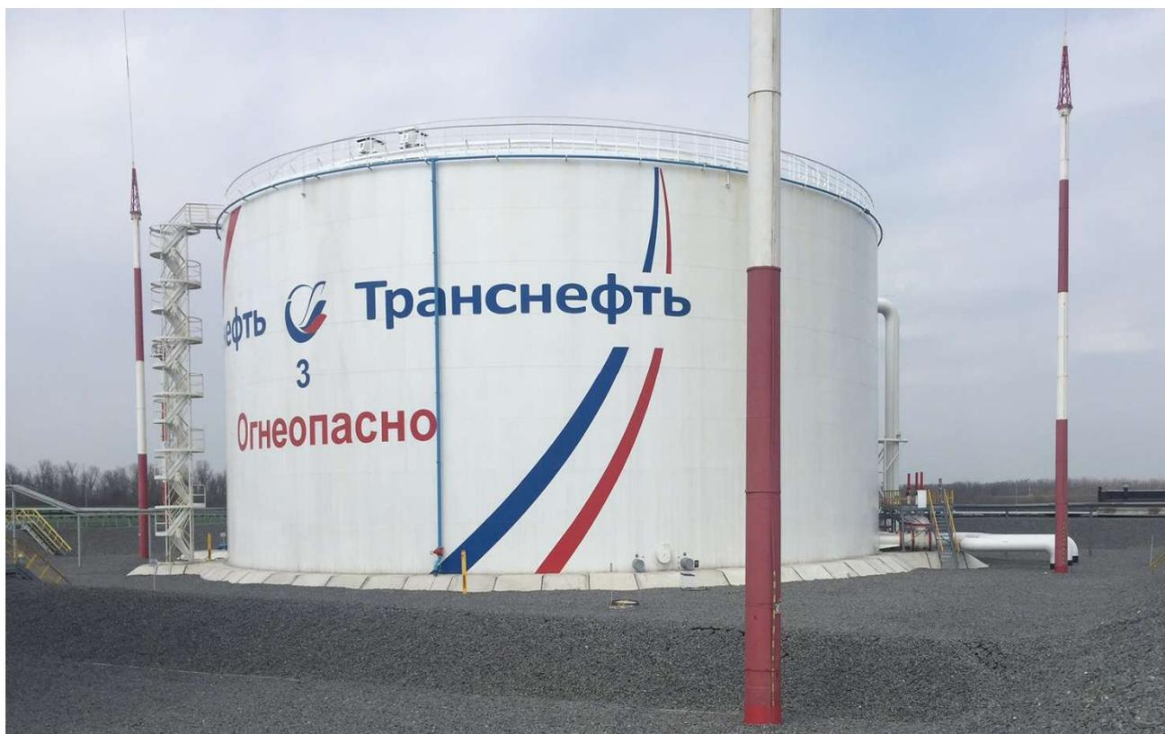
Рисунок 3 - Общий вид резервуара вертикального стального цилиндрического РВС-20000
