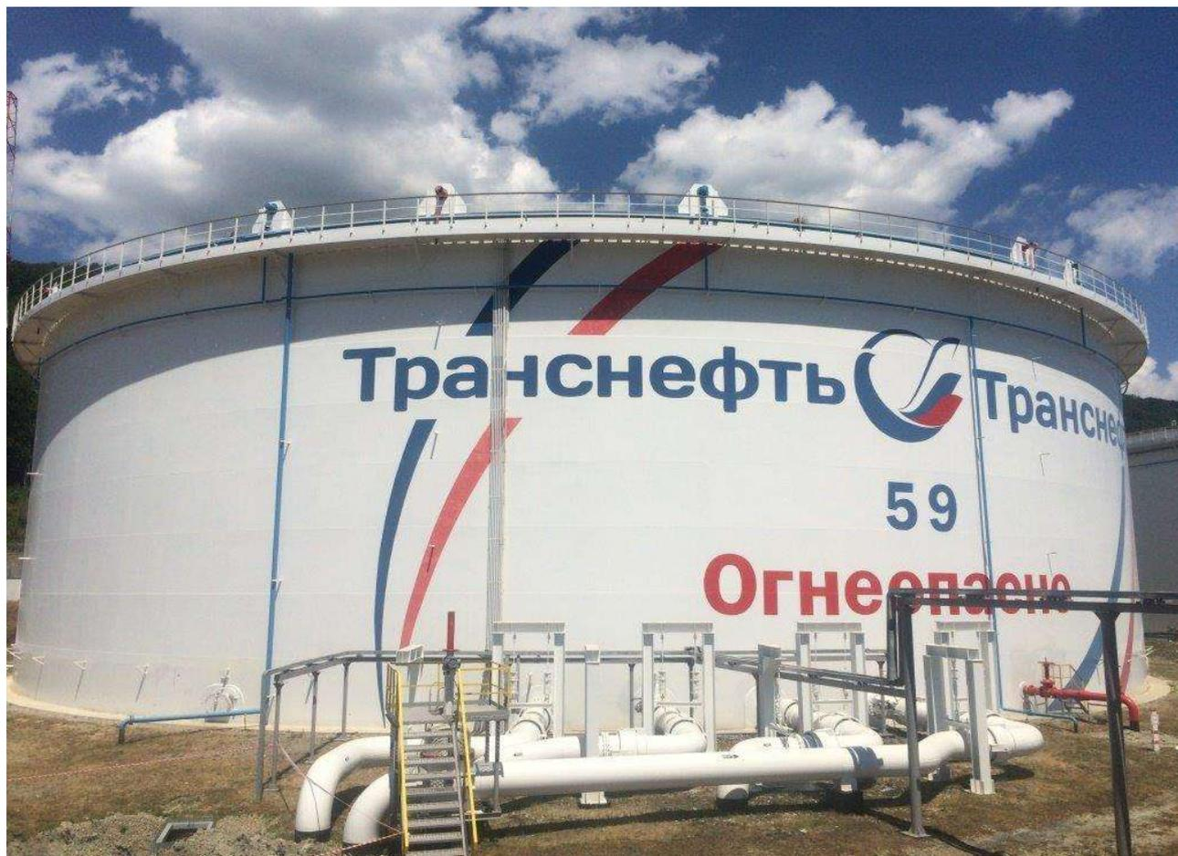
Рисунок 6 - Общий вид резервуара вертикального стального цилиндрического РВСПК-50000
