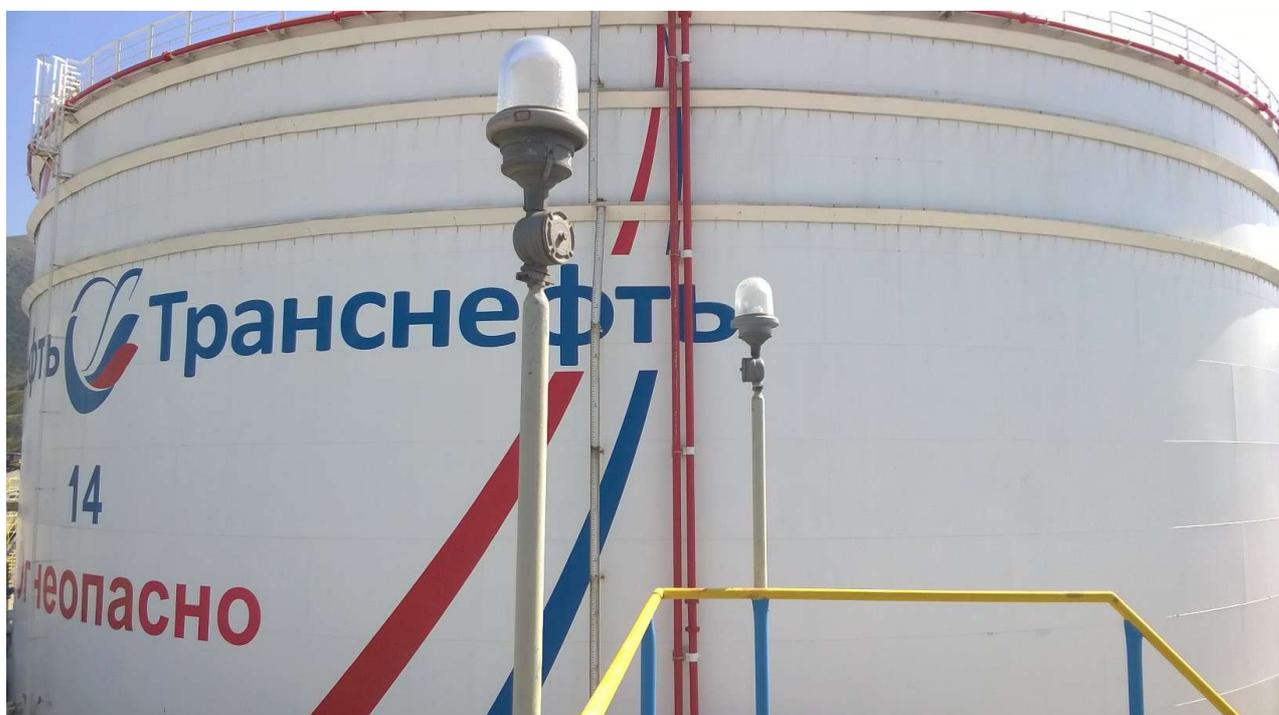
Рисунок 5 - Общий вид резервуара вертикального стального цилиндрического РВС-30000
