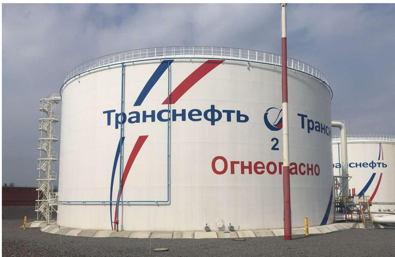
Рисунок 4 - Общий вид резервуара вертикального стального цилиндрического РВСП-20000
