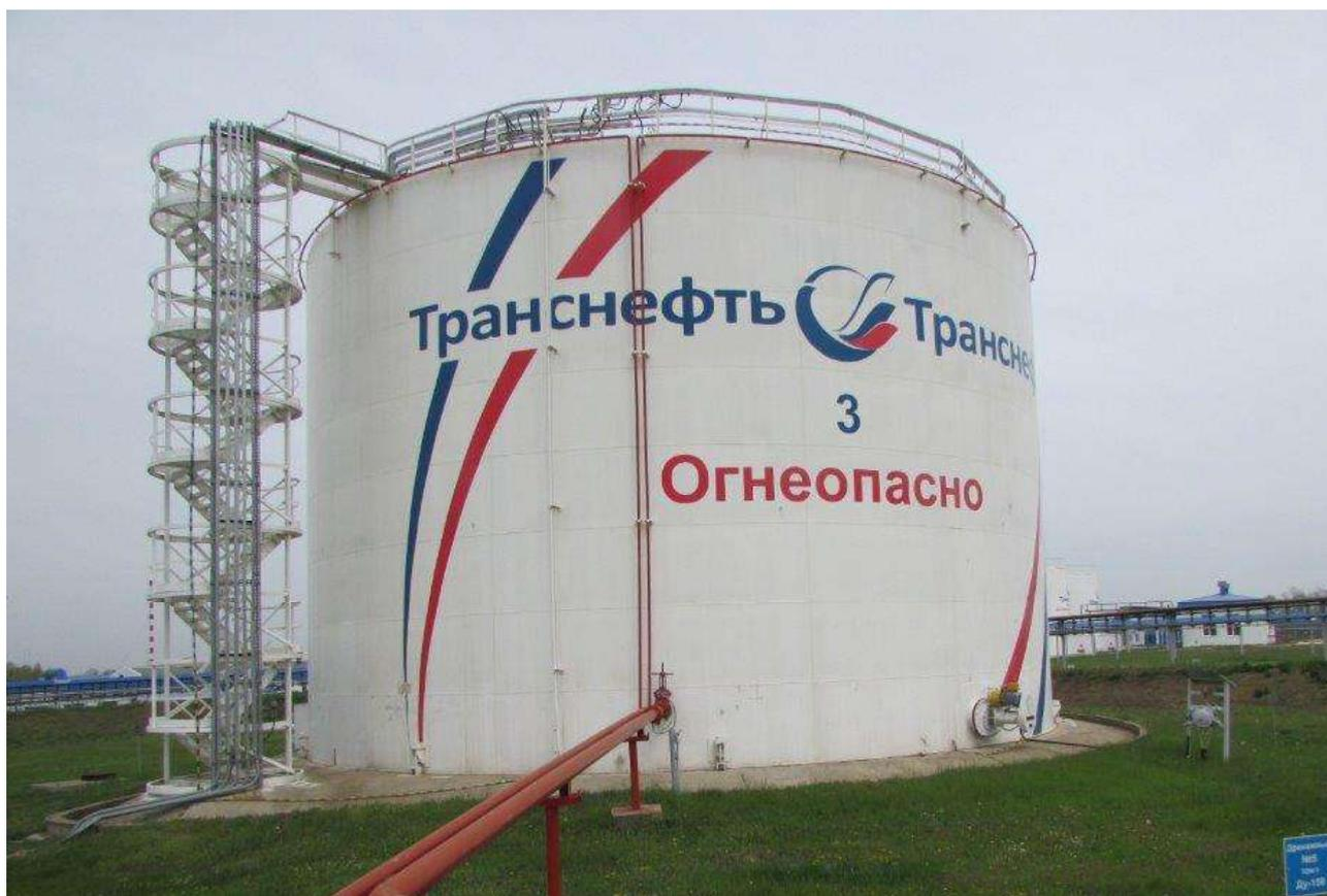
Рисунок 1 - Общий вид резервуара вертикального стального цилиндрического РВС-3000
