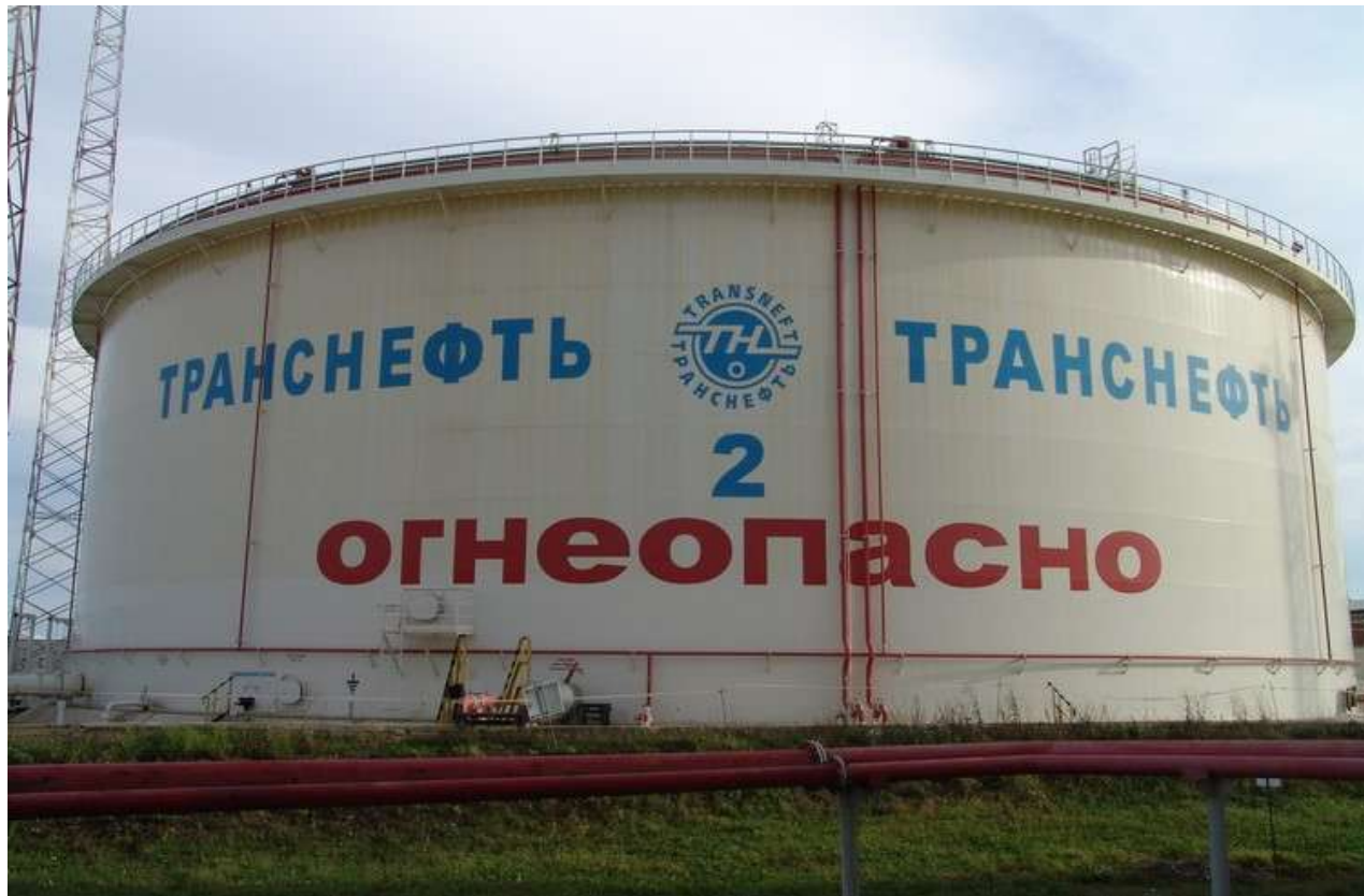
Рисунок 4 - Общий вид резервуара вертикального стального цилиндрического РВСПК-50000
