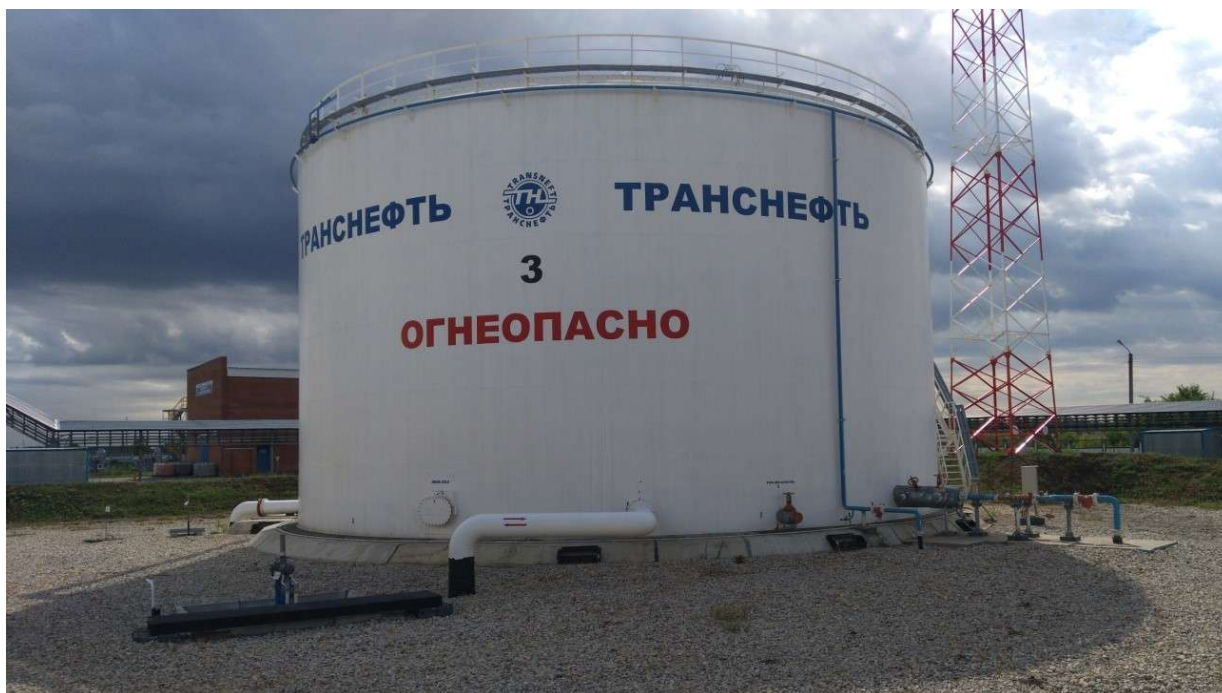
Рисунок 1 - Общий вид резервуара вертикального стального цилиндрического РВС-5000
