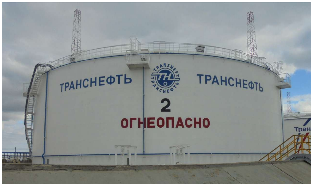
Рисунок 2 - Общий вид резервуара вертикального стального цилиндрического РВС-20000
