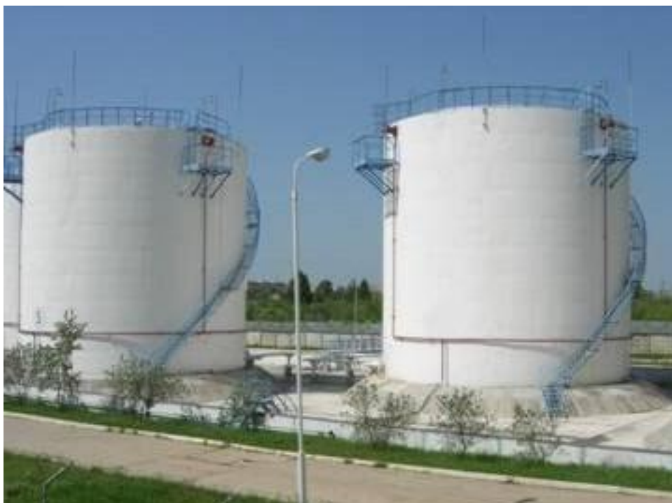
Рисунок 1 - Общий вид резервуаров
