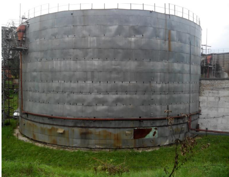
Рисунок 1 - Общий вид резервуара
