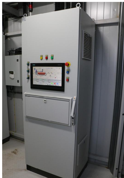
Рисунок 1 - Общий вид комплекса программно-технического «Smart - STEAM»
