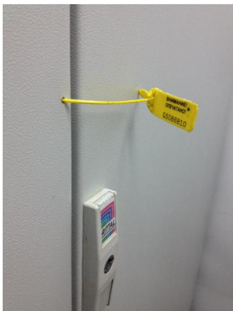
Рисунок 2 - Пломбировка шкафа СОО
