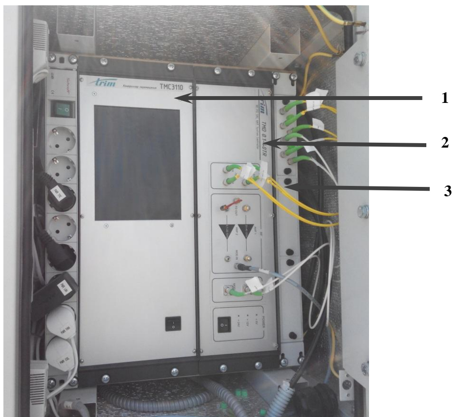
1 - контроллер перемещения ТМС3110, 2 - системный контроллер ТМО 0.1-40 TR, 3 - оптический бокс
