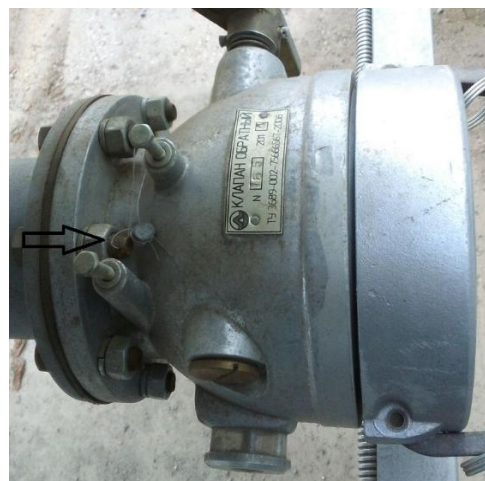
Рисунок 2 - Схема пломбировки от несанкционированного доступа, обозначение места нанесения знака поверки установки поверочной средств измерений объема и массы УПИМ-2000
