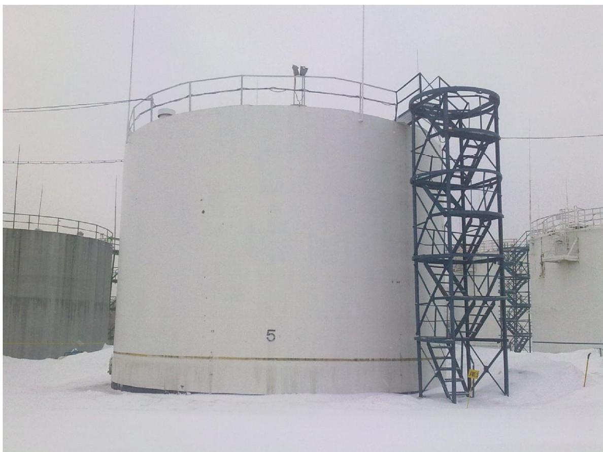
Рисунок 1 - Общий вид резервуара вертикального стального цилиндрического РВС-1000
