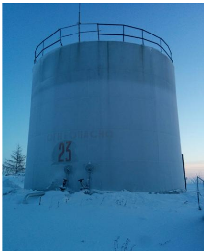
Рисунок 2 - Общий вид резервуара РВС-400
