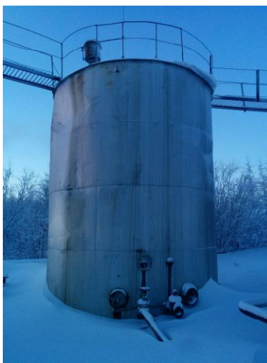
Рисунок 1 - Общий вид резервуара РВС-100
