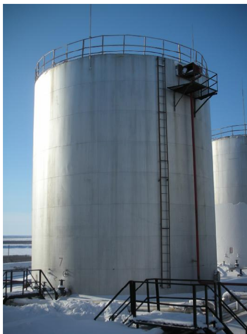
Рисунок 2 - Общий вид резервуара РВС-1000
