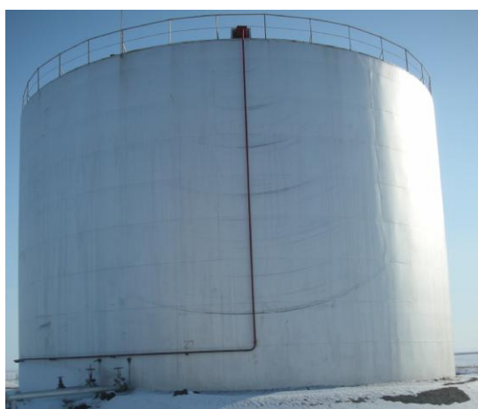
Рисунок 4 - Общий вид резервуара РВС-3000
