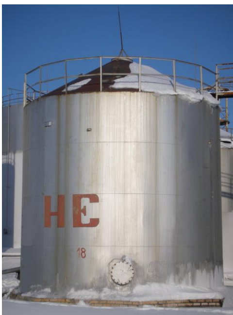
Рисунок 1 - Общий вид резервуара РВС-200
