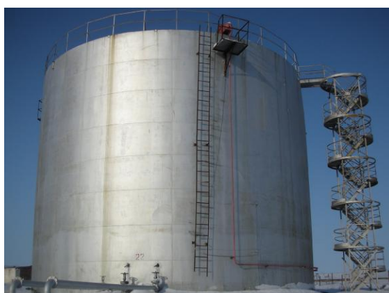
Рисунок 3 - Общий вид резервуара РВС-2000
