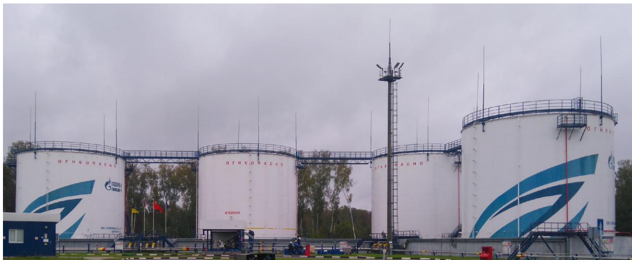
Рисунок 1 - Общий вид резервуаров
