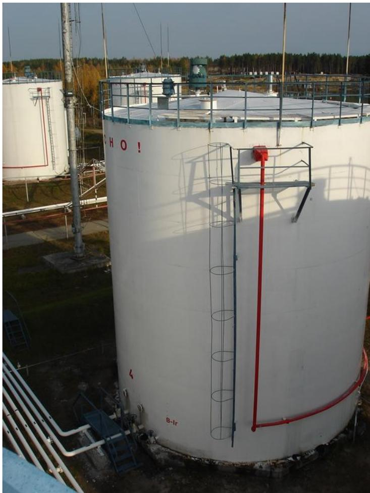
Рисунок 1 - Общий вид резервуара вертикального стального цилиндрического РВС-1000
