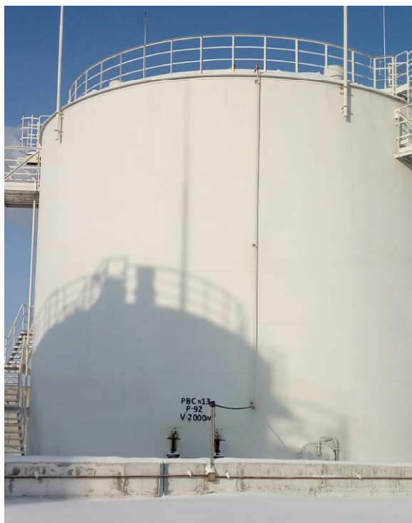
Рисунок 2 - Общий вид резервуара вертикального стального цилиндрического РВСП-2000
