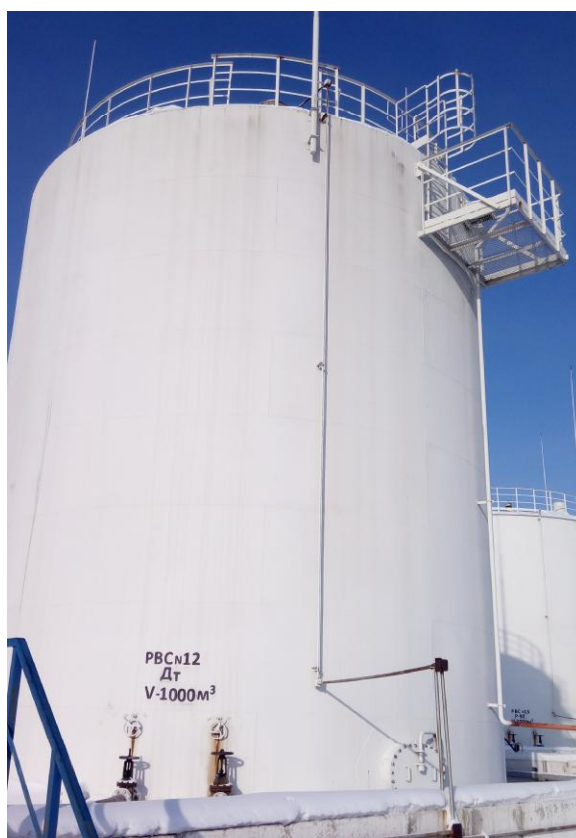
Рисунок 1 - Общий вид резервуара вертикального стального цилиндрического РВС-1000
