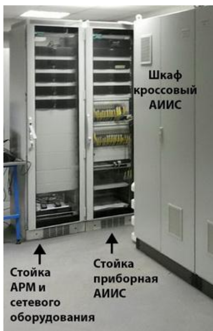
Рисунок 3 - Стойки и шкафы АИИС. Расположение
