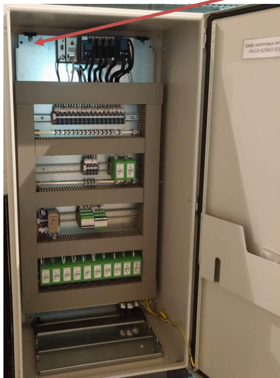
Рисунок 9 - Шкаф аналоговых сигналов 1
