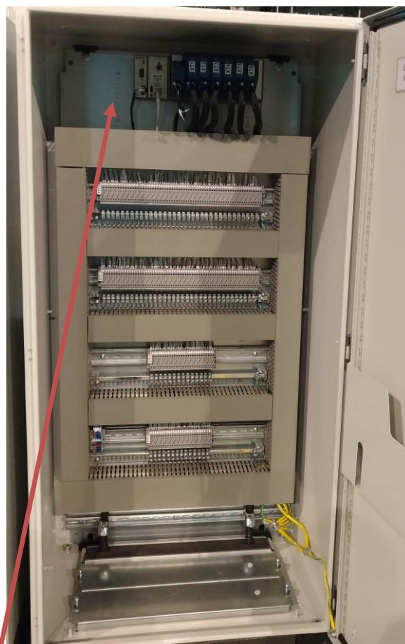
Рисунок 8 - Шкаф термопарный 2
