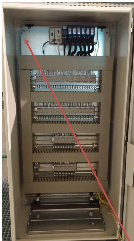
Рисунок 7 - Шкаф термопарный 1
