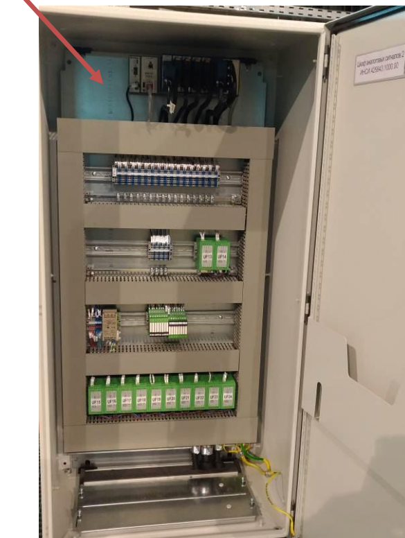
Рисунок 10 - Шкаф аналоговых сигналов 2
