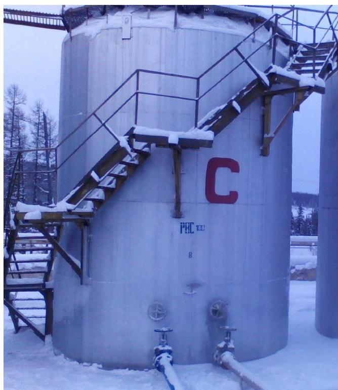
Рисунок 1 - Общий вид резервуара РВС-100
