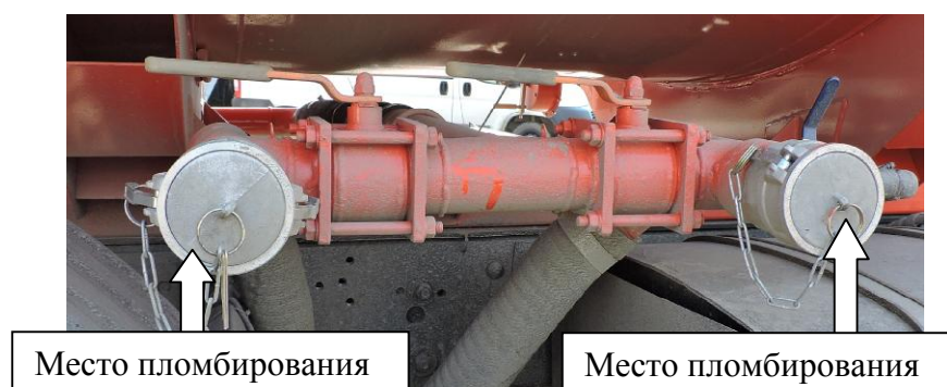
Рисунок 5 - Заглушка открывания трубопровода слива топлива из АТЗ
