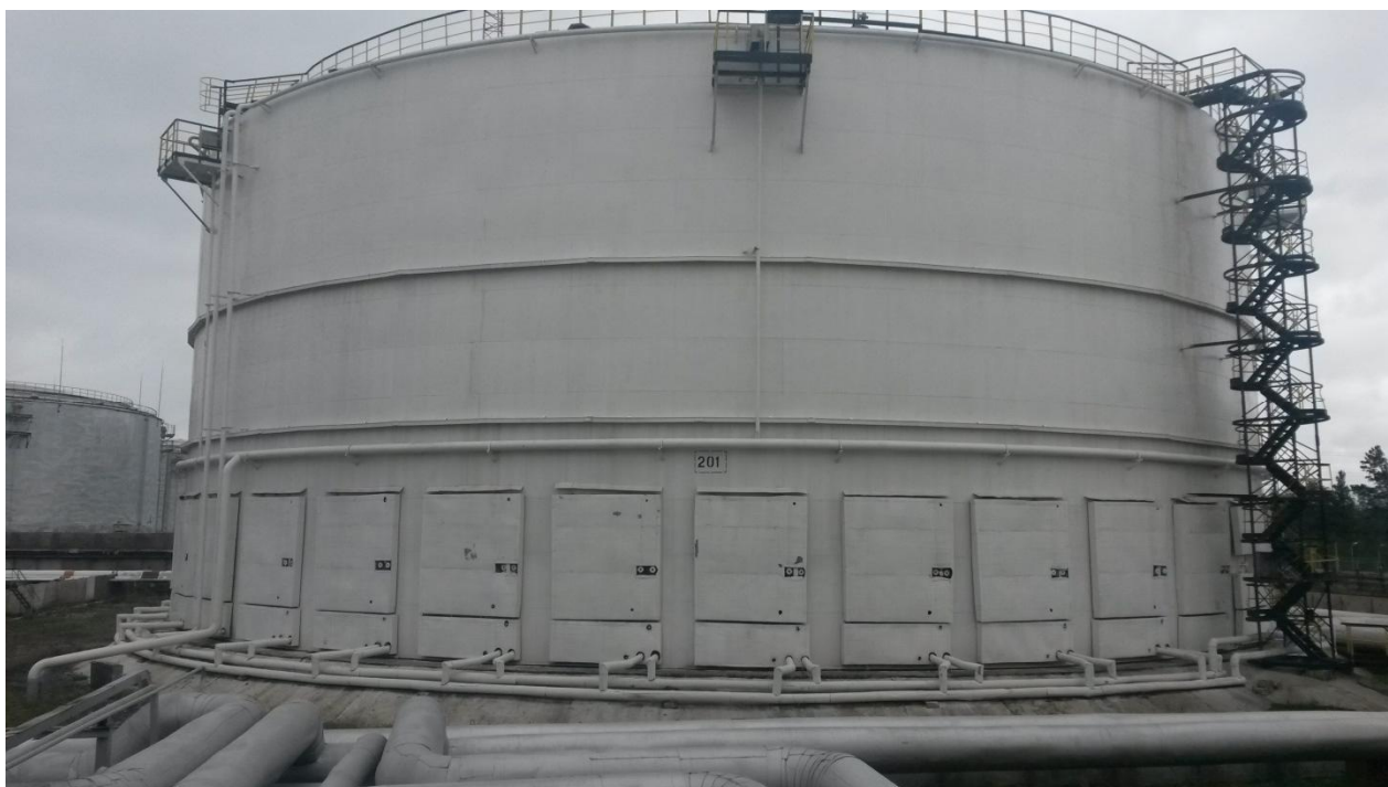
Рисунок 1 - Общий вид резервуара РВСП-30000
