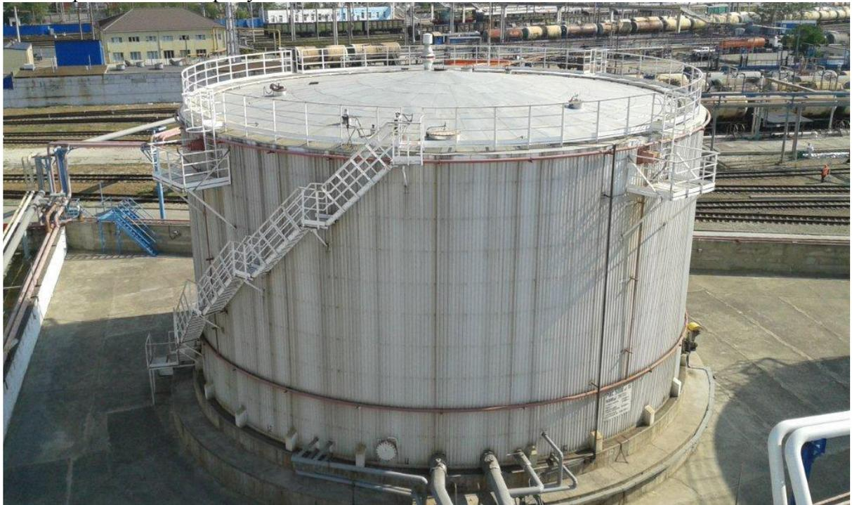
Рисунок 1 – Общий вид резервуара РВС-5000
