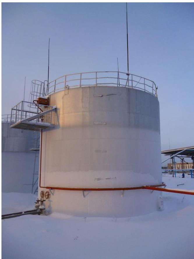
Рисунок 1 - Общий вид резервуара РВС-400
