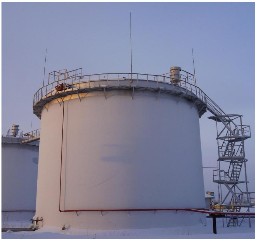
Рисунок 1 - Общий вид резервуара РВС-2000
